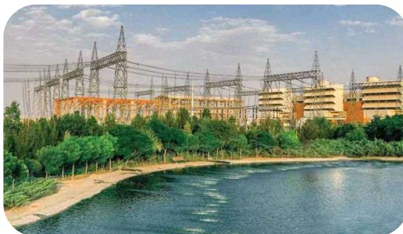
تصویر ۲- نیروگاه سیکل ترکیبی رودشور
